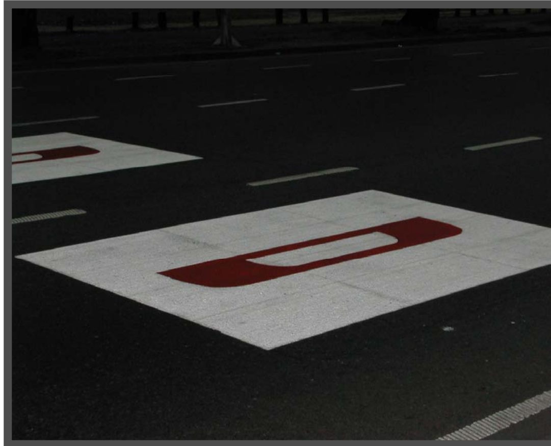
Espira Detectora Vehicular identificada con señal preformada en demarcación horizontal
