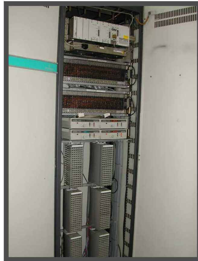
Sistema de Comunicaciones y Modems entre Comandos de Área y Comando Centralizado
