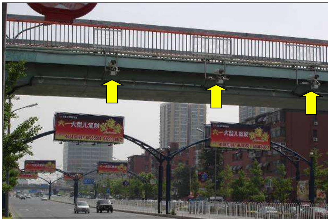
Radare a tripla tecnologia contano e classificano i veicoli
