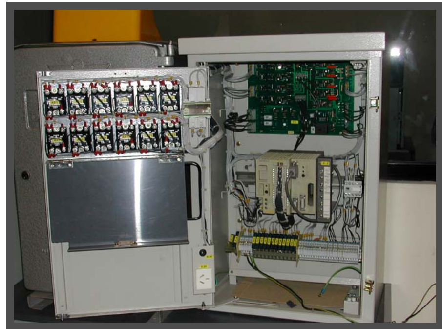
Equipo controlador Siemens CLS95 c/ Microprocesador
