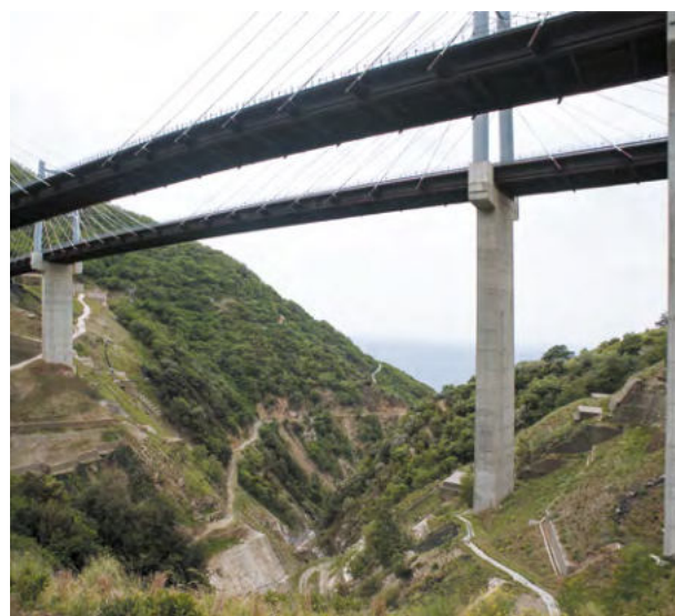
A2 - Autostrada del Mediterraneo - Viadotto Favazzina
